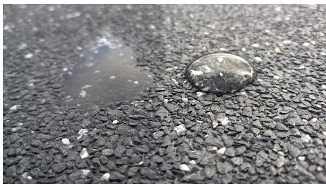
Слева: без обработки, поверхность пропускает воду. На фото демонстрируется микро-глубина вымывания бетонной поверхности
